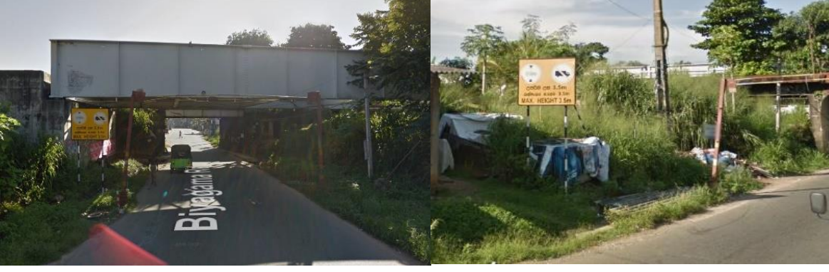
படம் 5.17 : உயர கட்டுப்பாட்டுப்பகுதி 4வது மைல்கல் ஆதாரம் : Google Earth Streetview, 2017
