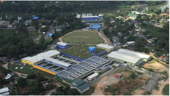
රූප සටහන 2.7 : කැලණි ගඟ දකුණු ඉවුර ජල පවිත්‍රාගාරය මූලාශ්‍රය : ජාතික ජලසම්පාදන සහ ජලපවිහන මණ්ඩලය, 2018
