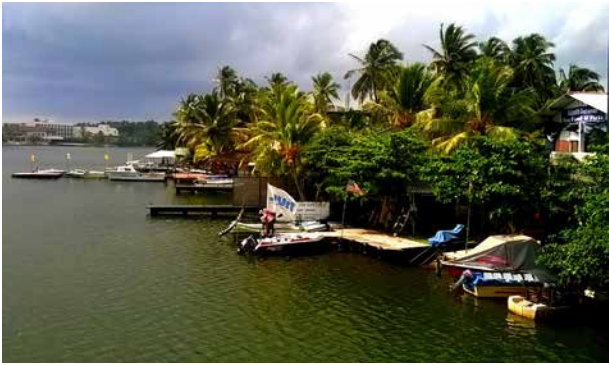
රූපය 3.7: බෙන්තර ගඟ රක්ෂිතයේ ඉදිකර ඇති අනවසර ඉදිකිරීම් මූලාශ්‍රය: ඡායාරූප ගත කිරීම, බේරුවල සැලසුම් කණ්ඩායම, කළුතර දිස්ත්‍රික් කාර්යාලය - 2018
