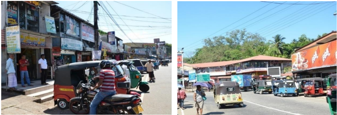
රූපය 3.2 : පුද්ගලික බස්නැවතුම්පල ඉදිරිපිට අක්‍රමවත් ත්‍රිරෝද හා රථ නැවතුම් හා වලනයන්
